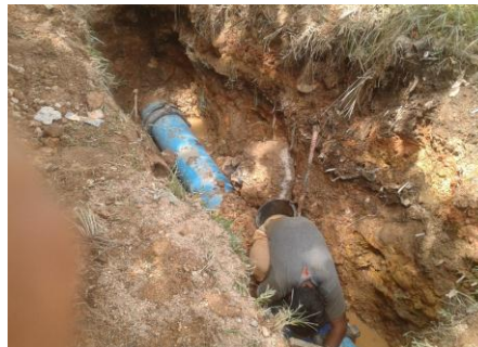
ภาพที่ 24 การซ่อมท่อน้ำประปาที่หาจุดได้จากข้อมูลภูมิสารสนเทศ
